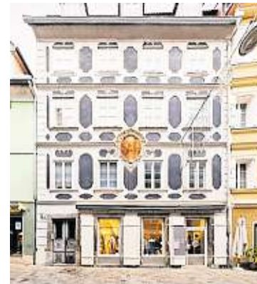
Barocke Prachtfassade in der Färbergasse 5. Hier wird auch ein Altbau mit einem Bauherrenmodell saniert
